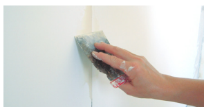
Traitement des joints
