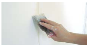
Traitement des joints
